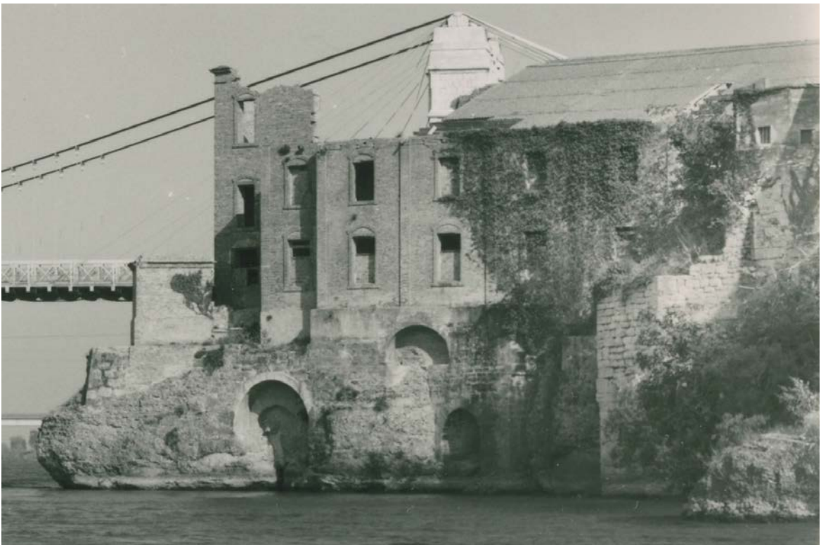
Detall de l'àmbit d'actuació (1960-1970) on s'aprecia l'estat de conservació del coronament del parament medieval lateral.
