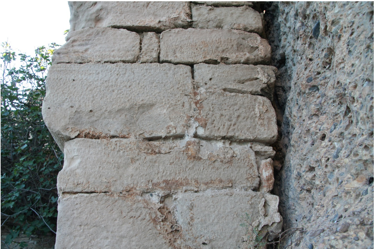
Detall del brancal esquerre de l'arc a l'alçada de la volada exterior. S'aprecia perfectament la separació entre aquest element i la roca, així com l'encintat bast que originalment cobria les juntes entre carreus.
