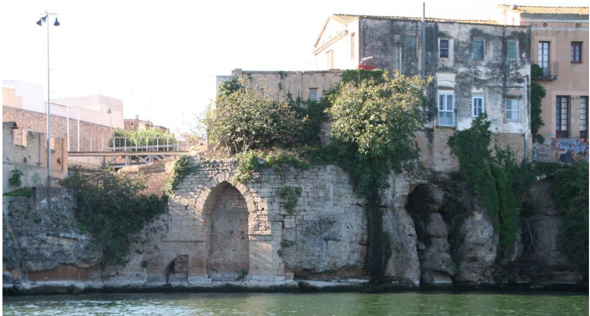
Vista general de l'àmbit de la façana pluvial on s'actua.
