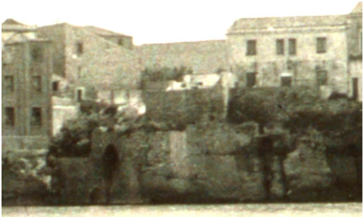
Detall de la fotografia anterior (any 1920) amb la part superior de la zona d'actuació sense vegetació arbustiva (figueres). S'intueix en el pany lateral l'esquerda associada al moviment de l'arc.
