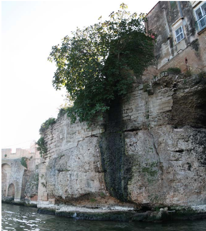
Detall de l'extrem del parament lateral on s'actua. S'observa l'impacte negatiu del desguàs de les aigües fecals de l'habitatge adjacent.
