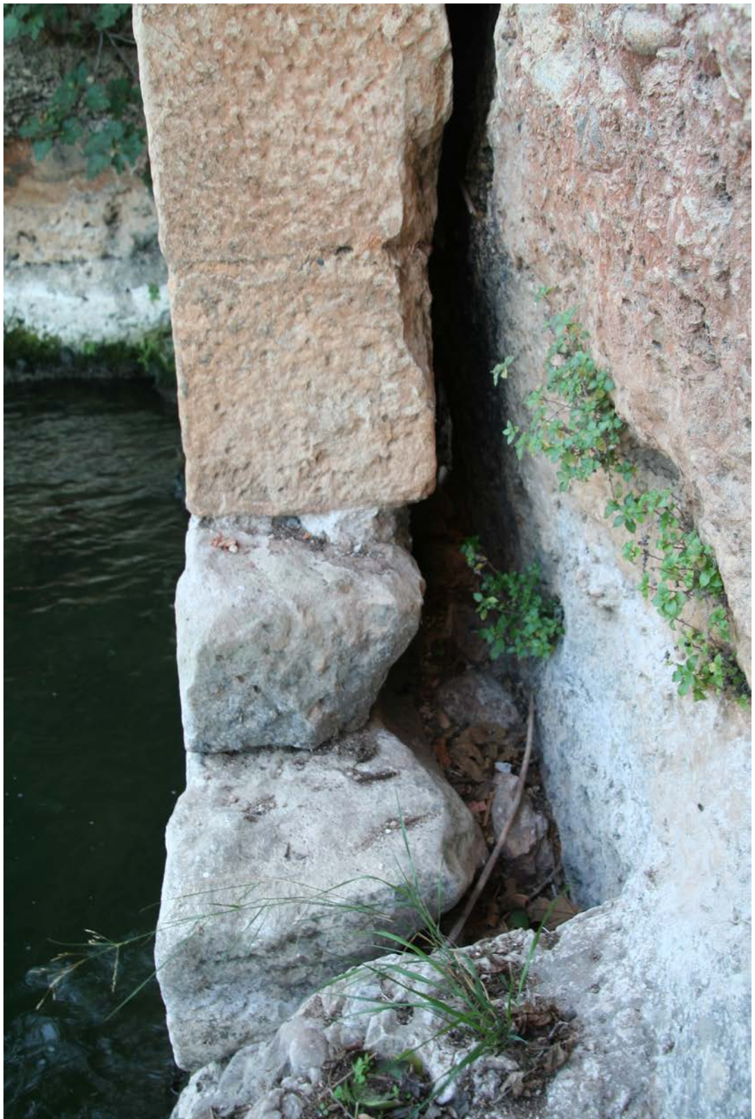
Detall de la part baixa d'un dels brancals de l'arc. La secció del mur arriba a reduir-se a poc més de 35 cm.
